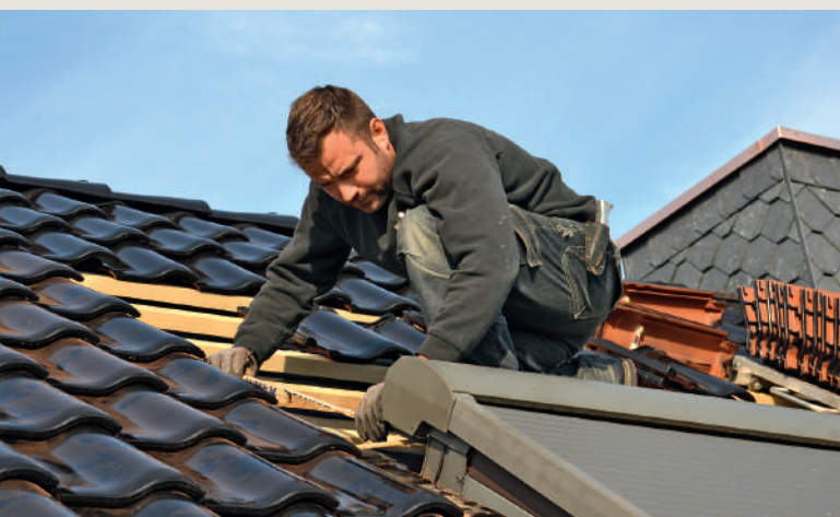
Danach arbeiteten die Dachdecker die Unterspannbahn an und abschließend wurden die Ziegel beigelegt.
