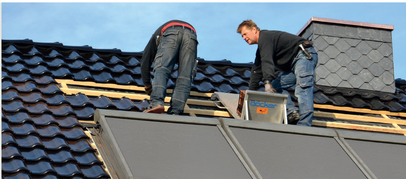
Die neuwertige Dachfensterkassette auf der Rückseite des Gebäudes blieb erhalten und wurde um Konterlattenebene angehoben.
